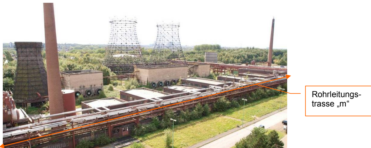
Abbildung 3 Kokerei Zollverein, Rohrleitungstrasse „m“ mit einer Länge von 209 Metern (Foto: Kornelius Götz).
