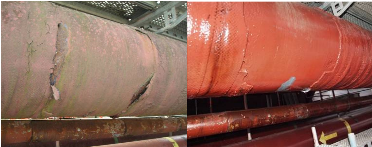
Abbildung 11 Kokerei Zollverein, Rohrleitungstrasse „m“, Behandlung der Rohroberflächen für das Restaurierungsziel „Erhaltung Ist-Zustand“, rechts vor, links nach der Behandlung (Foto: Kornelius Götz).
