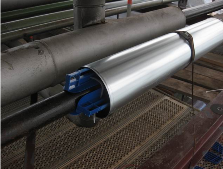
Abbildung 12 Kokerei Zollverein, Rohrleitungstrasse „m“, Behandlung der Rohrisolierungen für das Restaurierungsziel „Erhaltung Ist-Zustand“ (Foto: Kornelius Götz).
