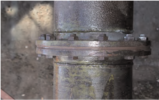
Abb. 9: Rohrtrasse „m“, asbesthaltige Dichtungen wurden versiegelt
