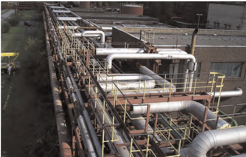
Abb. 8: Rohrleitungstrasse „m“ auf dem Gelände der Kokerei Zollverein
