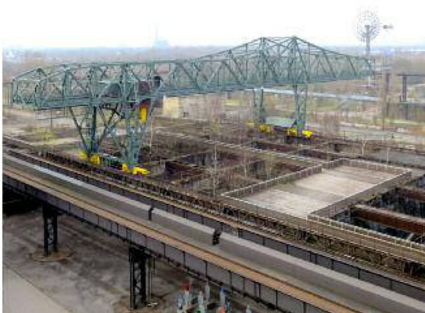
10./11 Beispiel Konservierung – Die Verladebrücke der Erzbunkeranlage im Landschaftspark Duisburg-Nord 1990/2001.
